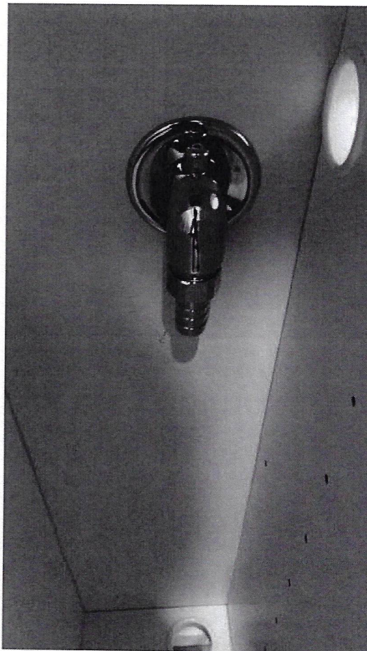
Seinälle asennettu pyykinpesukoneen poistokulma
