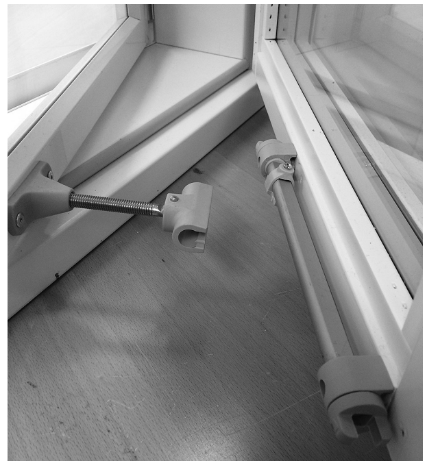
Liukukiskon lukitusvipu vaaka-asennossa (vapautettuna).
